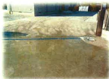
農業用水を隠した土間コンクリート
